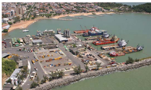
Figura 3 Porto de Imbetiba foto atual
