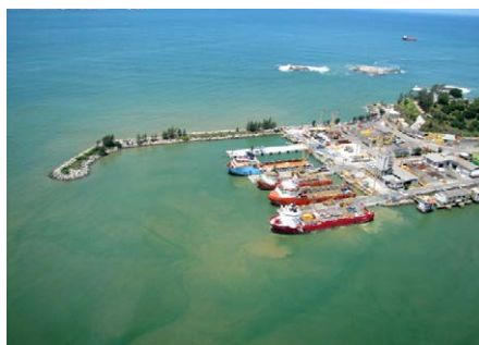
Figura 2 Porto de Imbetiba foto atual
